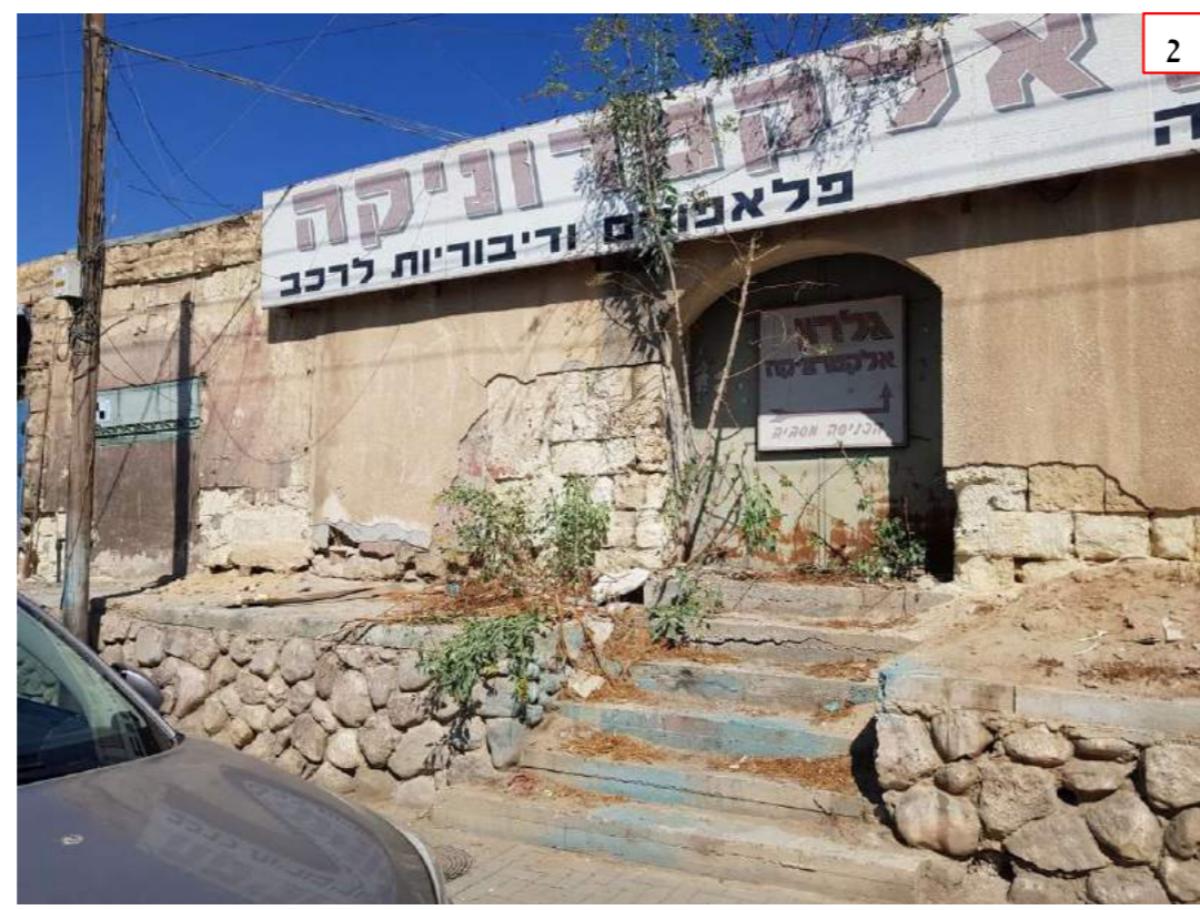
חזית דרום מזרחית – פונה לרחוב שלושת בני עין חרוד חזית במצב טוב אשר חופתה בטיח על בסיס צמנט אשר מזיק לאבן הטבעית. ניתן לראות את החומה ומדרגות שנבנתה בין השנים 1961-1979.
