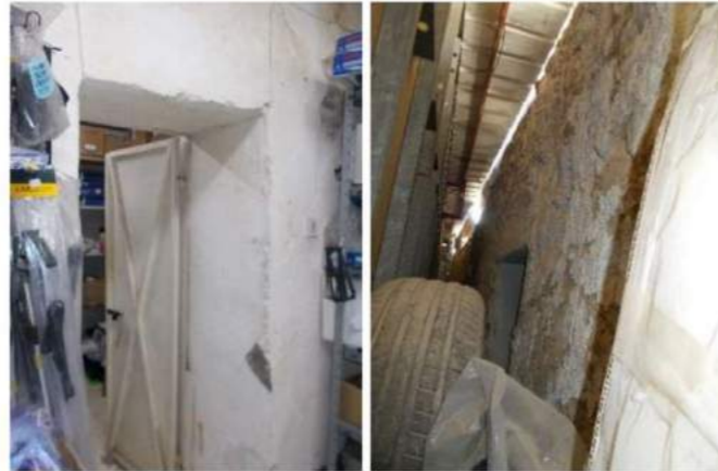
איור 13- קיר מקורי מאחורי קיר פח איור 14- קיר נושא פנימי
